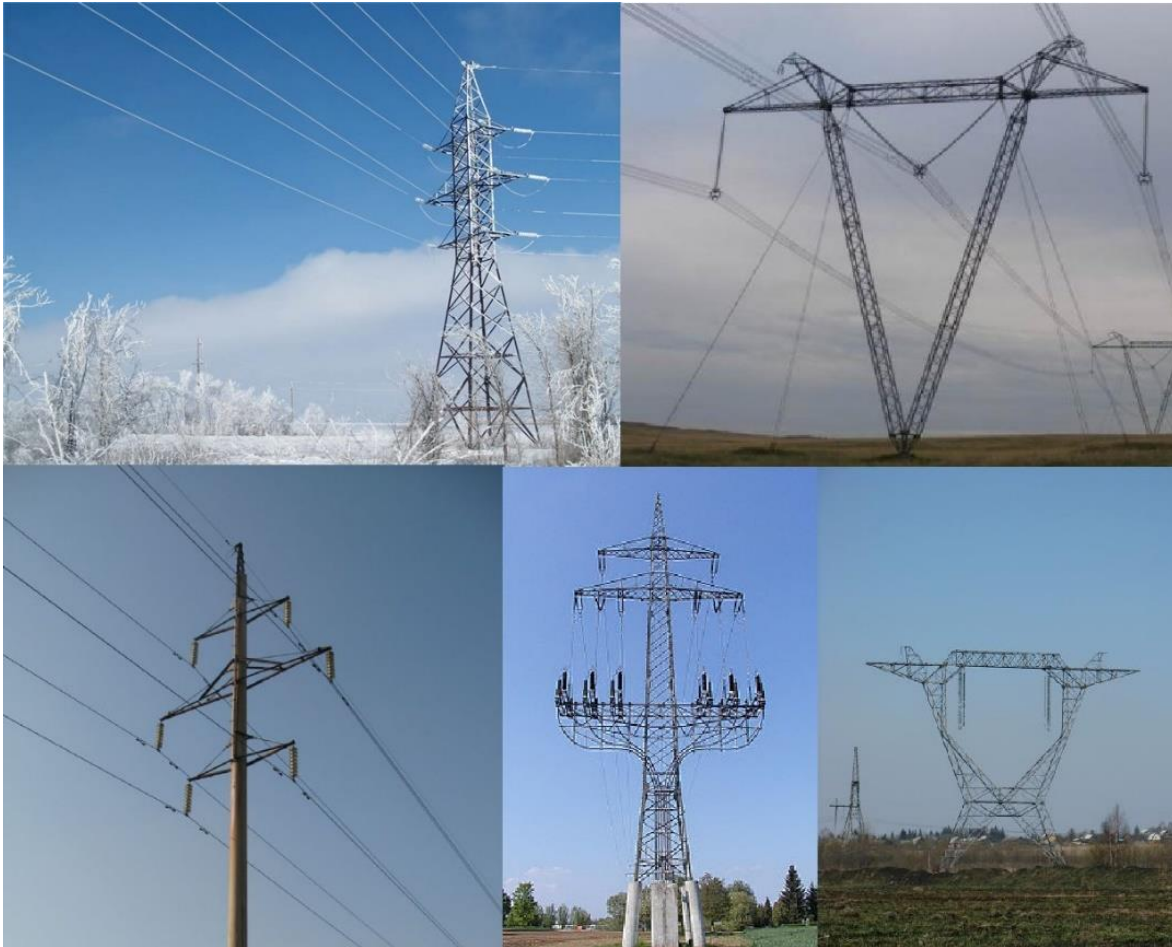
Рис. 1. Опори ліній електропередачі
