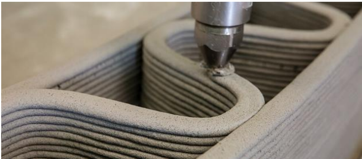
Пошарове нанесення бетонної суміші.
