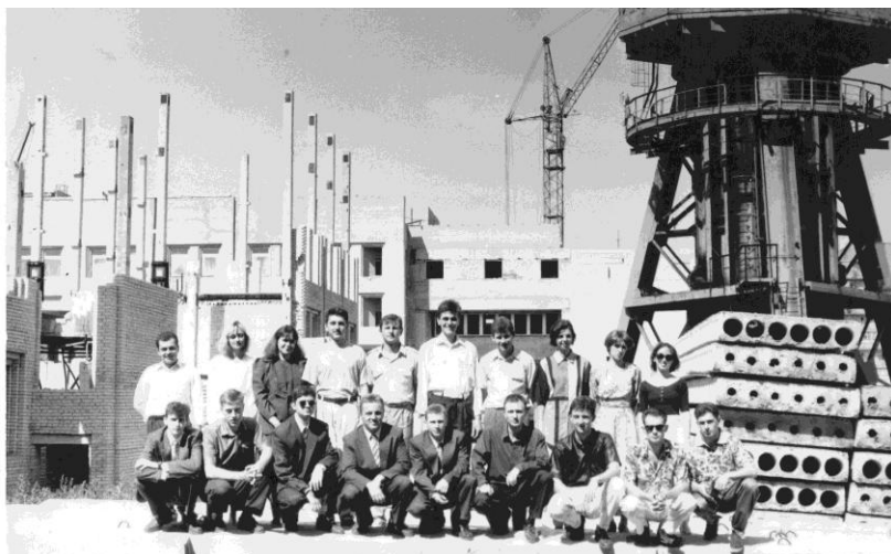
Будівництво головного корпусу СНАУ, 1998 р.
