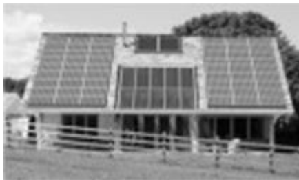
Рис.1 Загальний вигляд енергозберігаючого будинку
