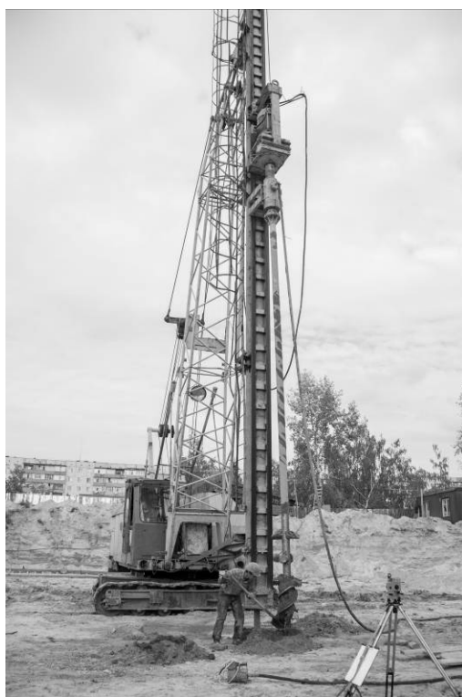
Рис.3 Обладнання для влаштування ґрунтоцементних фундаментів з високочастотним глибоким вібруванням: а – РДК-250 з навісним буровим обладнанням; б – глибокий вібратор ИВ-117 на гнучкому валу.
