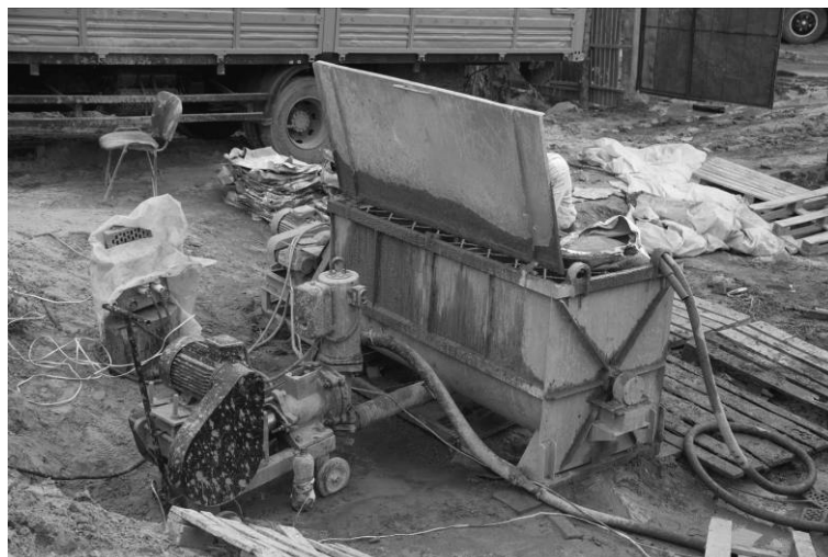
Рис. 2 Комплект обладнання для подачі водоцементного розчину, насос СО-50 та лопатевий змішувач.
