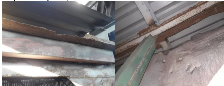
Рисунок.1 Ураження верхніх поясів ферм пластовою корозією з істотним зменшенням перерізу.
