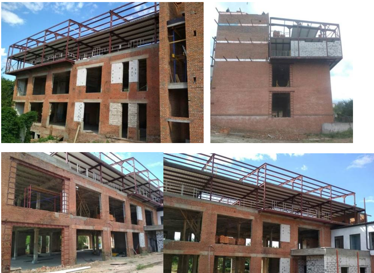
Рис. 1 Будівля до реконструкції
