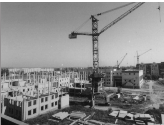
Будується головний корпус
