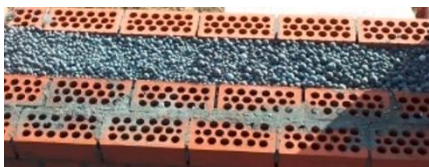
Рис. 4. Конструкція стіни з використанням керамзиту
