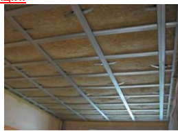
Рис.2. Звукоізоляція стелі
