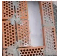
Рис. 5. Конструкція стіни з використанням перліту
