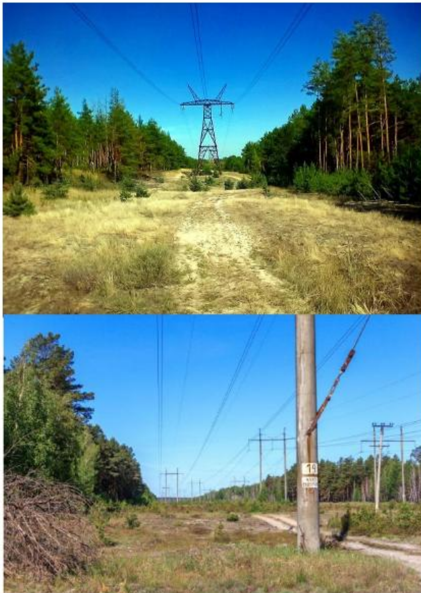
Рисунок 1. Просіки ліній електропередачі
