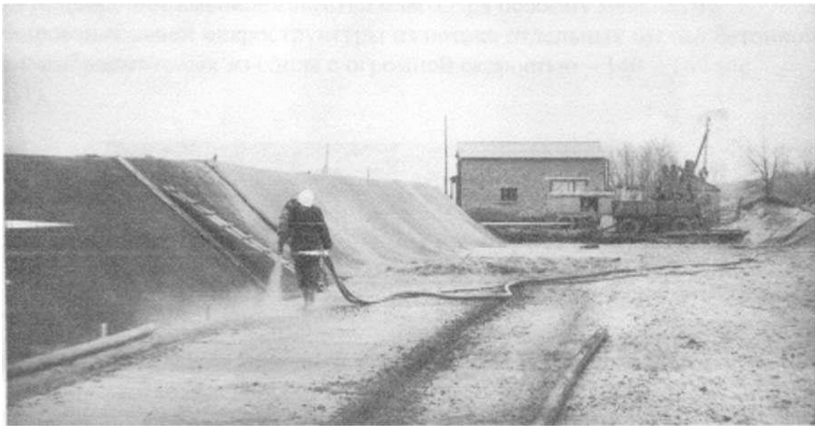
Рис. 3 Мобільний агрегат пневмо-бетонування на будівництві наземного силососховища.
