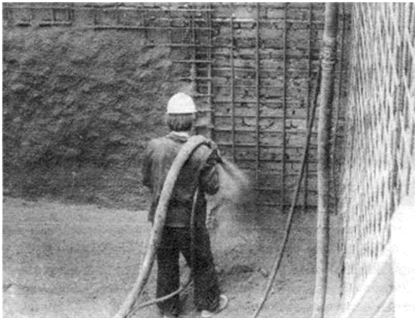
Рис. 2. Бетонна суміш при виході із сопла.
