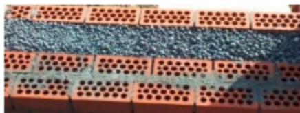
Рис. 3. Конструкція стіни з використанням керамзиту
