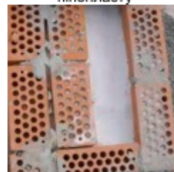
Рис. 4. Конструкція стіни з використанням перліту
