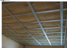
Рис.2. Звукоізоляція стелі
