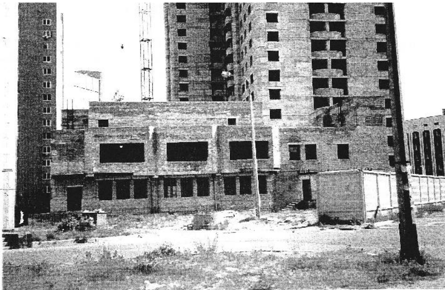
Рис.1. Загальний вигляд будівлі за адресою вул.Маршала Тимошенко, 2 в м. Києві до реконструкції
