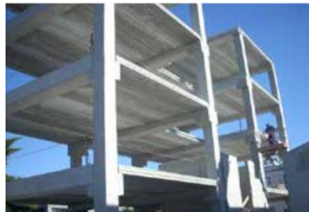
Рис.1. Загальний вигляд багатопорожнинної плити (а); перекриття багатопверхових будинків багатопорожнинними плитами – одне з можливих застосувань плит
