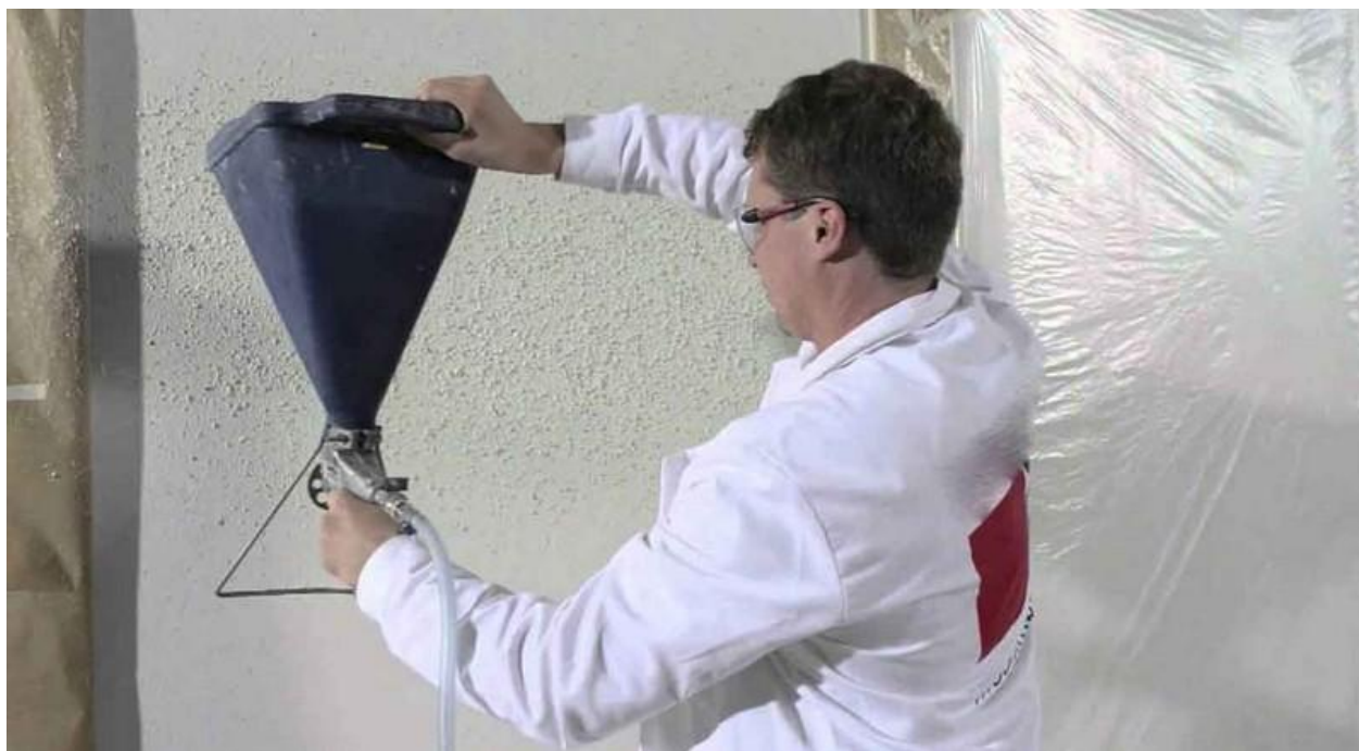
Рис. 2.5. Нанесення за допомогою пістолета з компресором
