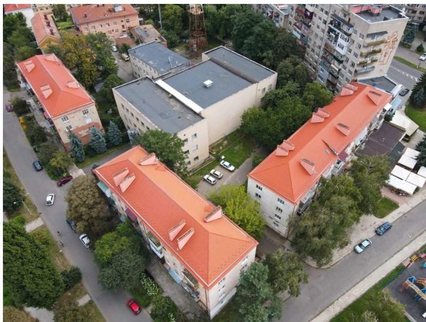
Рис 2.2. Загальний вид вальмового покриття
