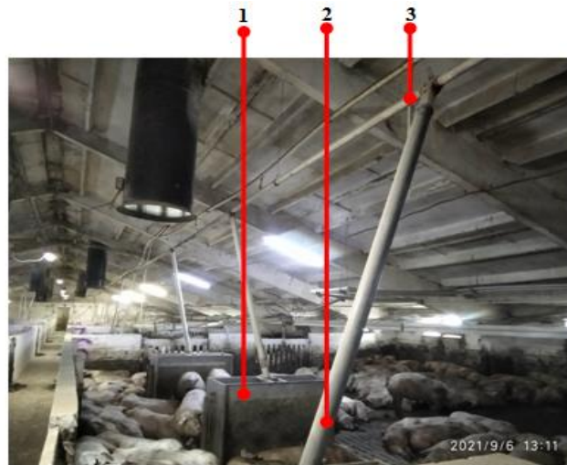
Рис. 2.19 Система подачі сухого корму для свиней І (контрольної) групи
