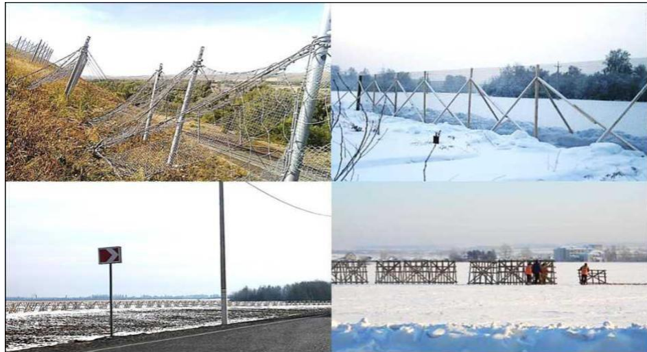
Рисунок 1.3 - Приклади облаштування бар'єрів (перешкод) для затримки снігу за умови відсутності лісових насаджень
