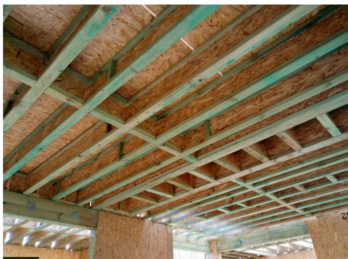
Фото 3.18. Монтаж ОСБ 18мм по двотаврових балках через вібраційну мембрану. Основа підлоги другого поверху.
