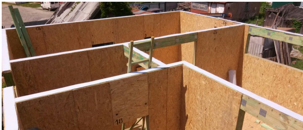
Фото 3.14.Монтаж обв'язуючої балки першого поверху.
