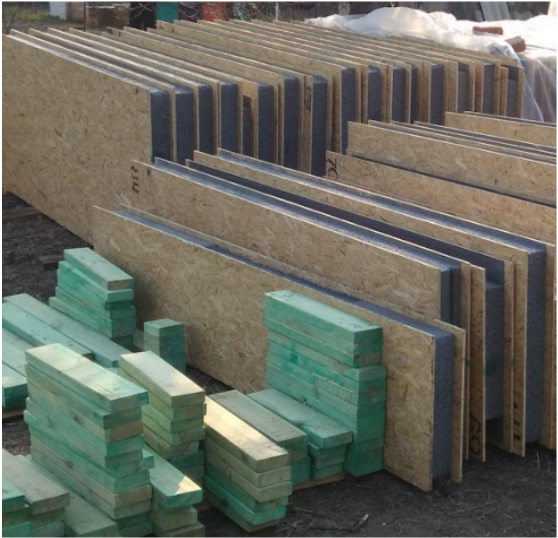
Фото 2.2. Загальний вигляд СІП з наповнювачем - графітовий пінополістирол.
