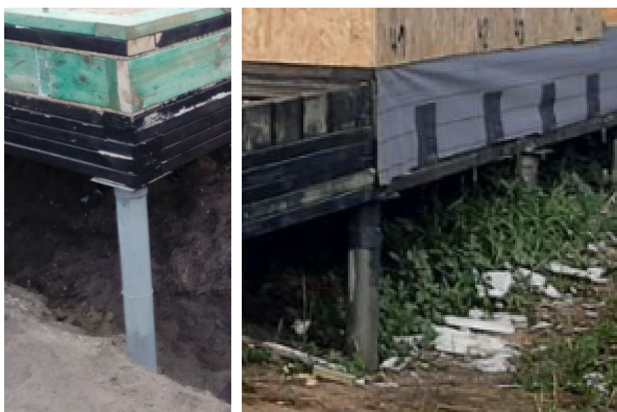
Фото 3.10 - 3.11. Монтаж СІП підлоги.
