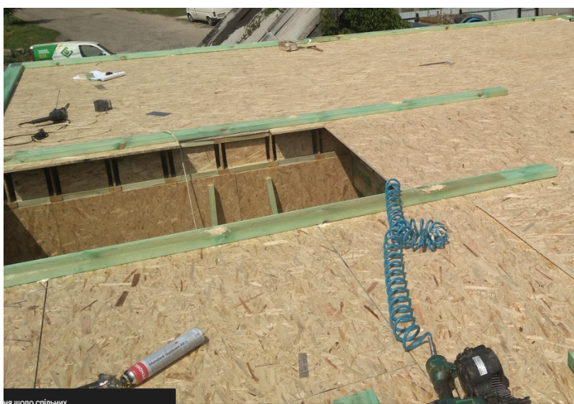
Фото 3.18. Монтаж ОСБ 18мм по двотаврових балках через вібраційну мембрану. Основа підлоги другого поверху.
