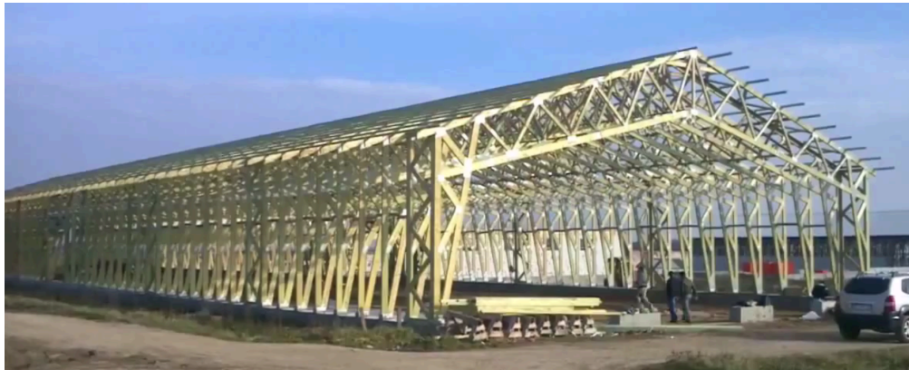
Фото 2.34. Дерев'яна конструкція шириною 21 метр без опор.
