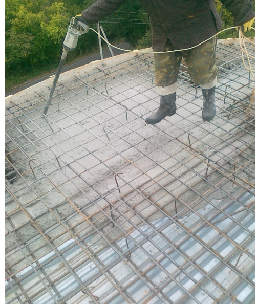
Рис. 2.2.6. Заливка монолітної плити перекриття
