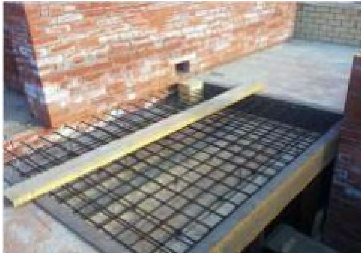
Рис.2.2.1.Монолітні залізобетонні перекриття
