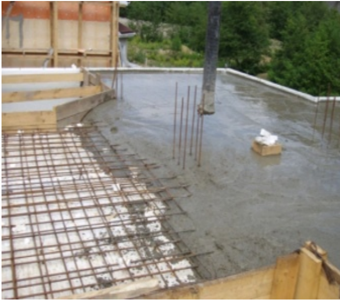
Рис. 2.2.6. Заливка монолітної плити перекриття
