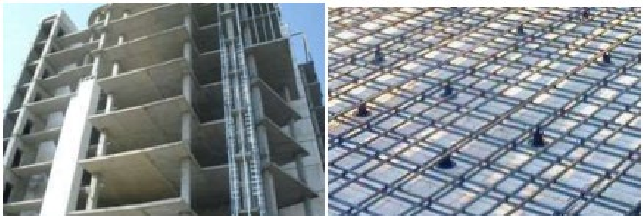
Рис. 2.2.3. Монолітне перекриття
