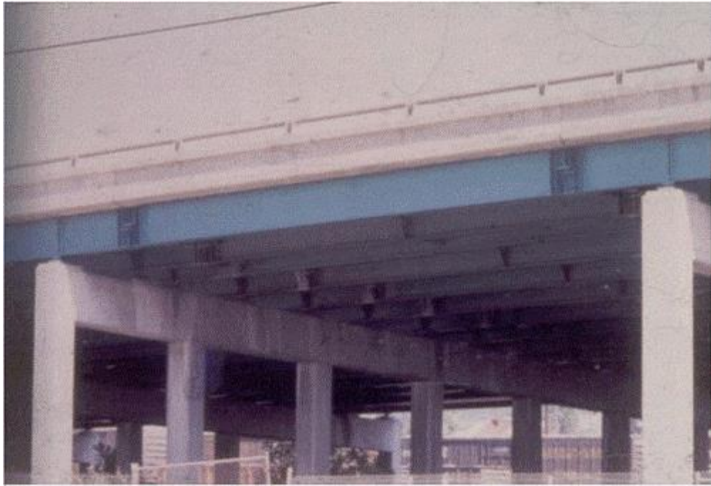
Рис. 1.1 Балки залізобетонної мостової споруди [13]
