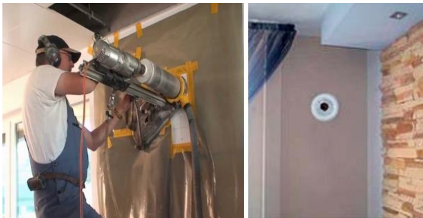
Рис.6. Технологічний процес влаштування рекуператора
