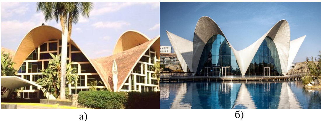
Рис. 2.1 Покриття у вигляді гіпарів: ресторан готелю Casino de la Selva, Куернавака, Мексика-а; L'Oceanogràfic (El Oceanogràfico), Місто мистецтв і наук, Валенсія, Іспанія, з Альберто Домінго та Карлосом Лазаро-б
