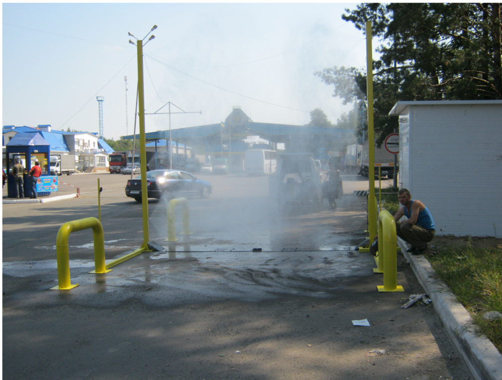
Рис.8. Місце проведення дезінфекції транспорту на пропускному пункті, автоматична система «АСАД-15Г».
