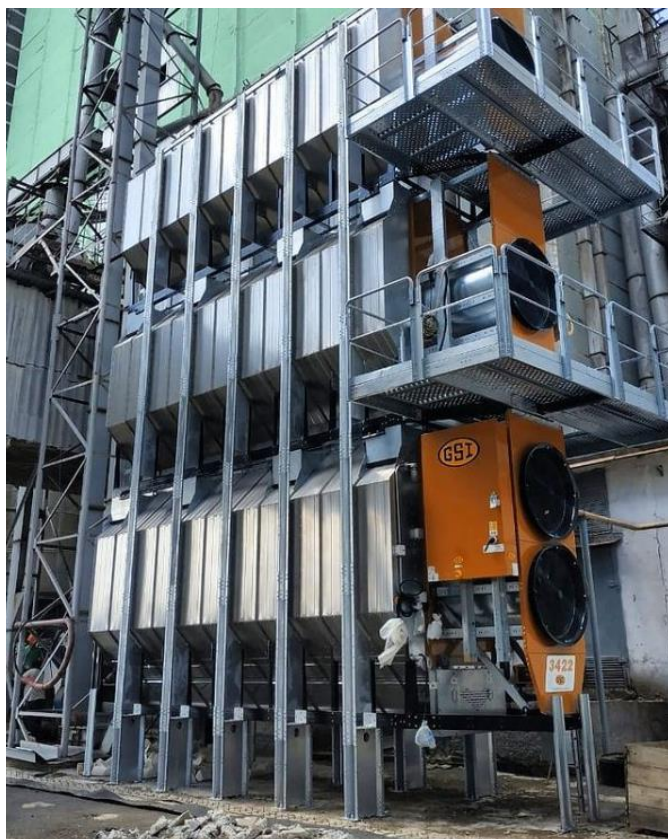
Рисунок 4. 3-х модульна зерносушарка марки GSI моделі 3422 Сумська область, село Біловод, Кернел елеватор
