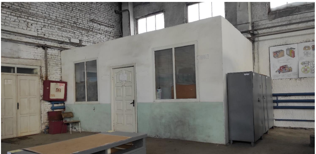
Рисунок 8. Підсобне приміщення ремонтної майстерні
