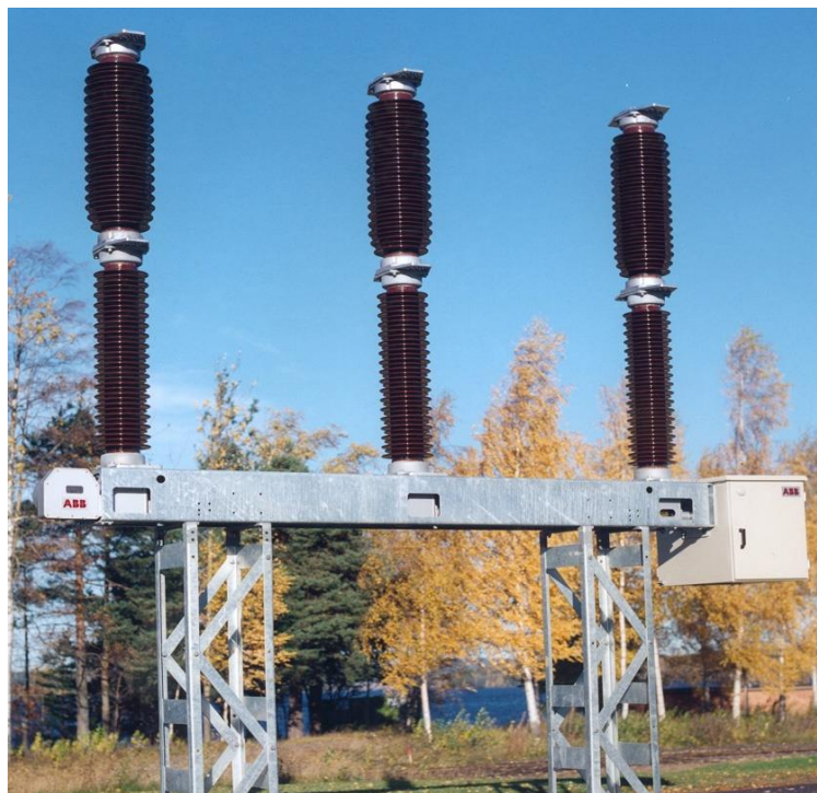
Рис. 2.1. Елегазовий колонковий вимикач серії LTB 145D1/В з пружинним приводом BLK 222.
