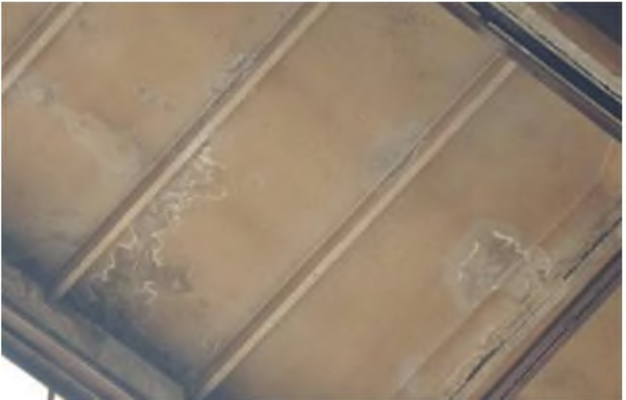
Рис. 3. Замочування ребристої плити покриття.
