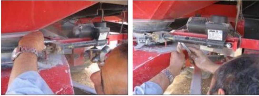
Рис. 8 - Доналаштування в електричних приводах
