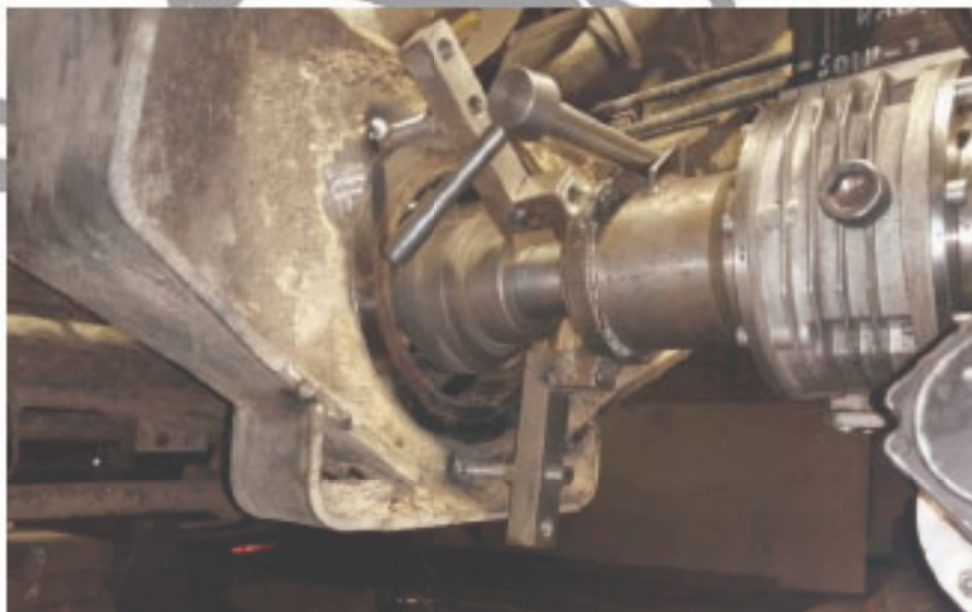
Рисунок 2.1 – Технологічний процес проведення ремонтних робіт балансиру трактора New Holland
