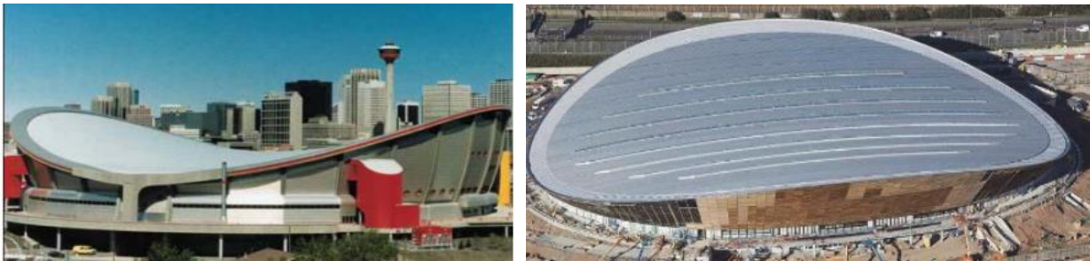
Рисунок 3.2. Монолітні сідлоподібні оболонки
