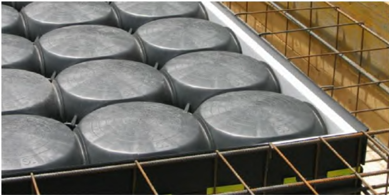
Рисунок 3.12 - Монолітне полегшене перекриття системи Veeplate
