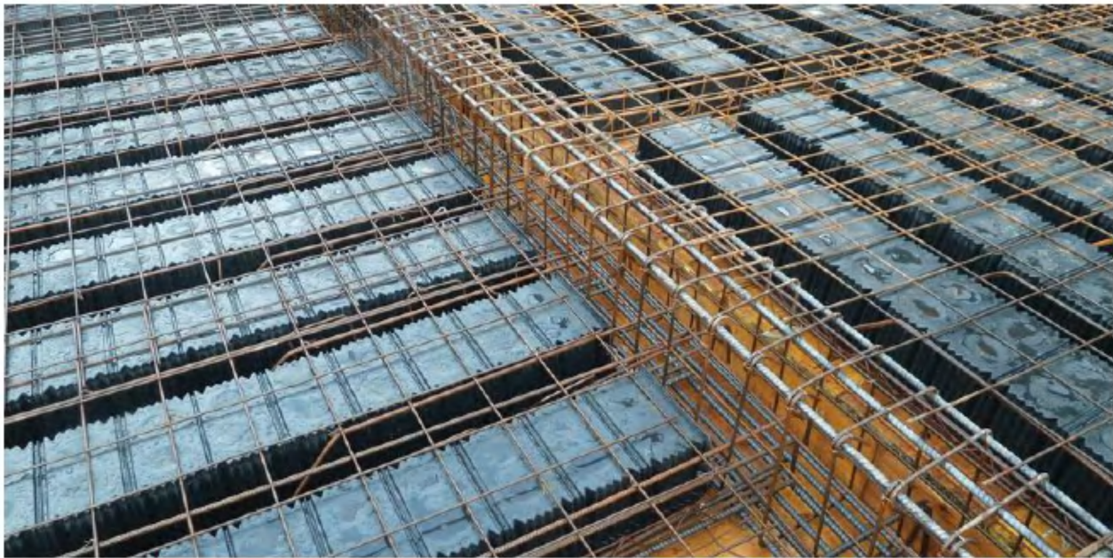
Рисунок 3.10 - Монолітне полегшене перекриття системи U-BahnBeton
