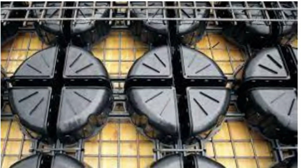
Рисунок 3.9 - Монолітне полегшене перекриття системи Sobiax
