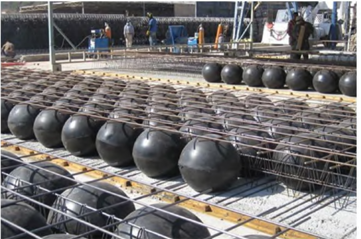
Рисунок 3.8 - Монолітне полегшене перекриття системи BubbleDeck
