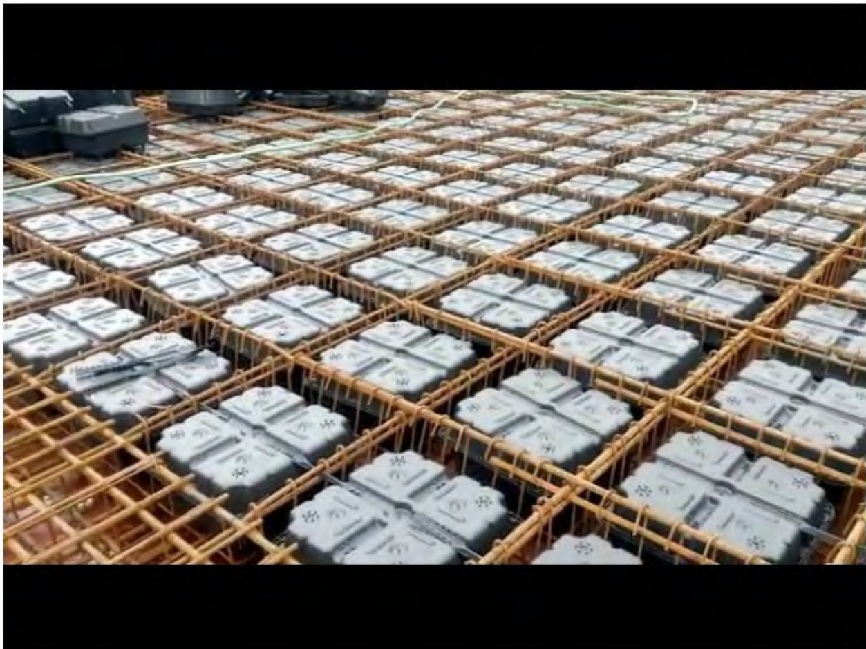
Рисунок 3.11 - Монолітне полегшене перекриття системи U-BootBeton
