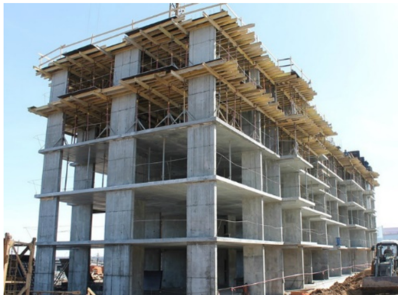
Рис. 3.1. Будівництво будівлі з плоским безбалковим перекриттям.
