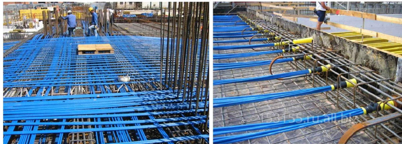
Улаштування монолітного перекриття з попереднім напруженням без зчеплення з бетоном
