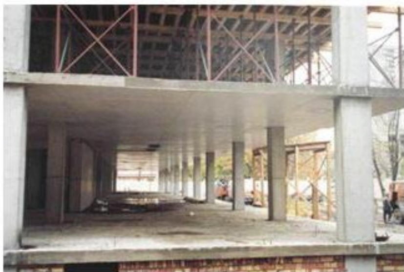
Рис. 3.1 Залізобетонне плоске перекриття
