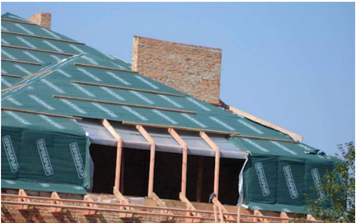
Рисунок №10 Влаштування супердифузійної мембрани
