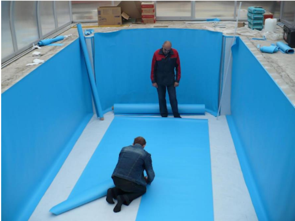
Рисунок №12 Влаштування полімерної мембрани
