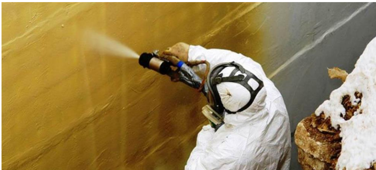
Рисунок №2 Влаштування полісечовини метолом набригту
