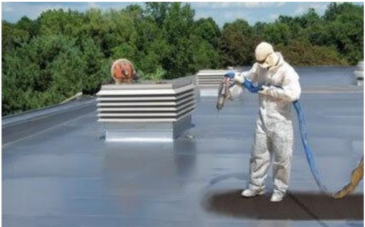
Рисунок №4 Влаштування полісечовини метолом набриггу
