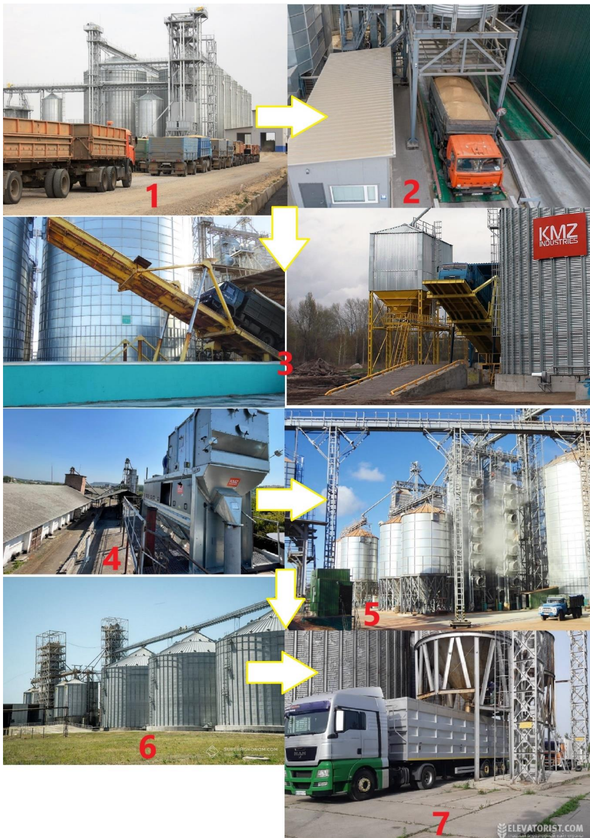
Рисунок 1.4. Функціональні завдання елеваторів. 1. Прийом; 2. Аналіз; 3. Розвантаження; 4. Очищення; 5. Сушіння; 6. Зберігання; 7. Відвантаження
