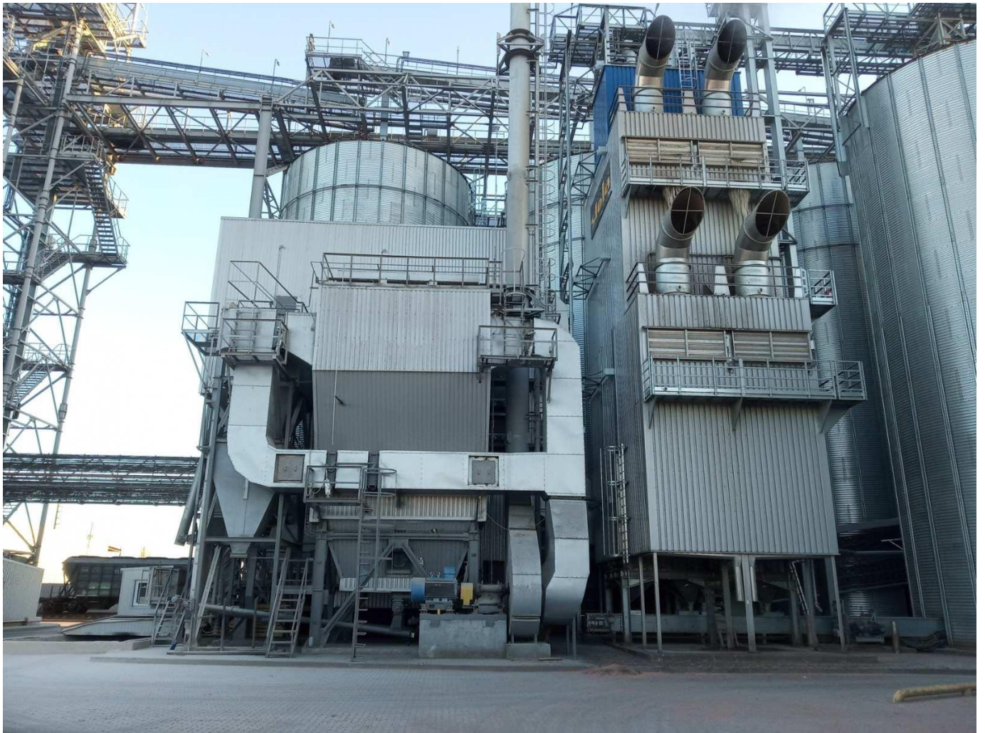
Рисунок 3.1. Загальний вигляд шахтної зерносушарки смт. Степанівка
