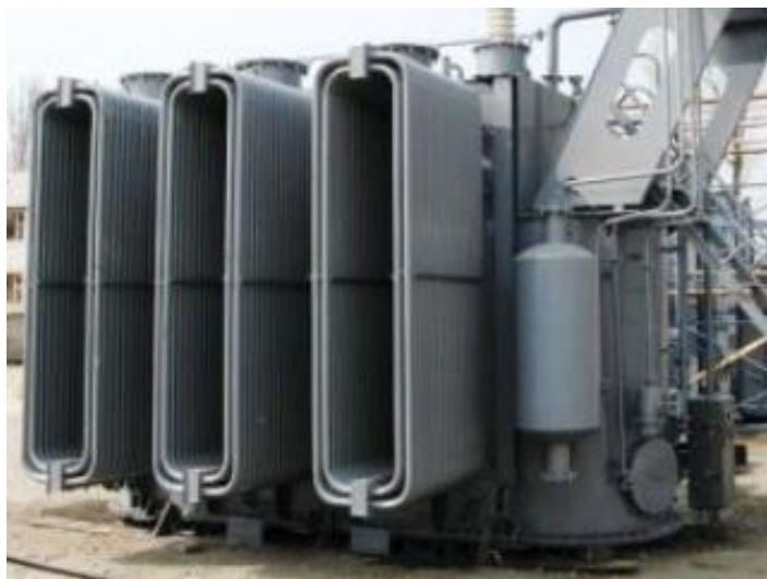
Рисунок 1.1 – Силовий трансформатор типу ТРДН-40000/110/6
