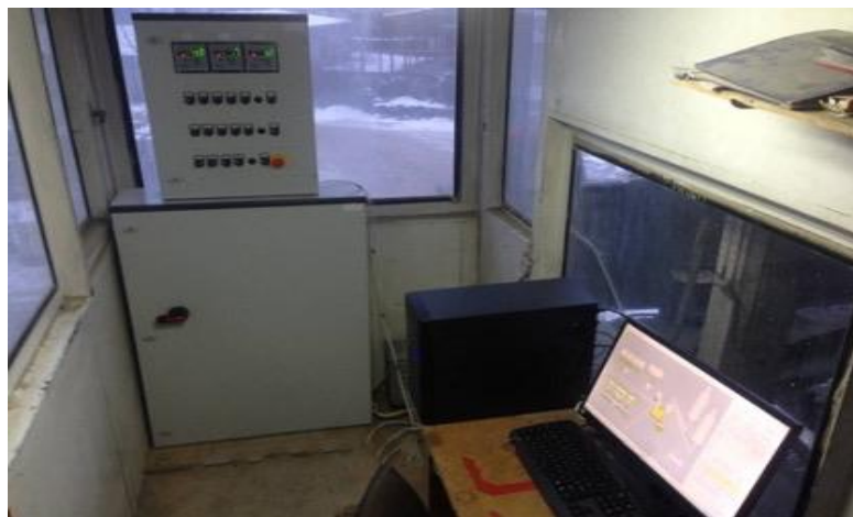
Рисунок 4.4 – АСУ комплексом БЗУ-60
