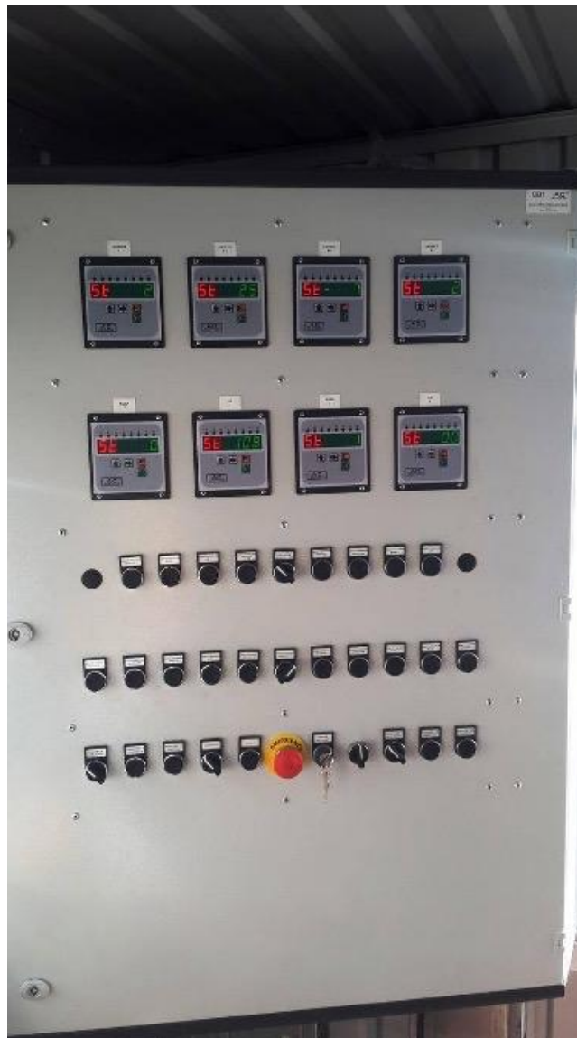
Рисунок 4.7 – Контрольно-вимірювальна апаратура системи управління комплексом БЗУ-60
