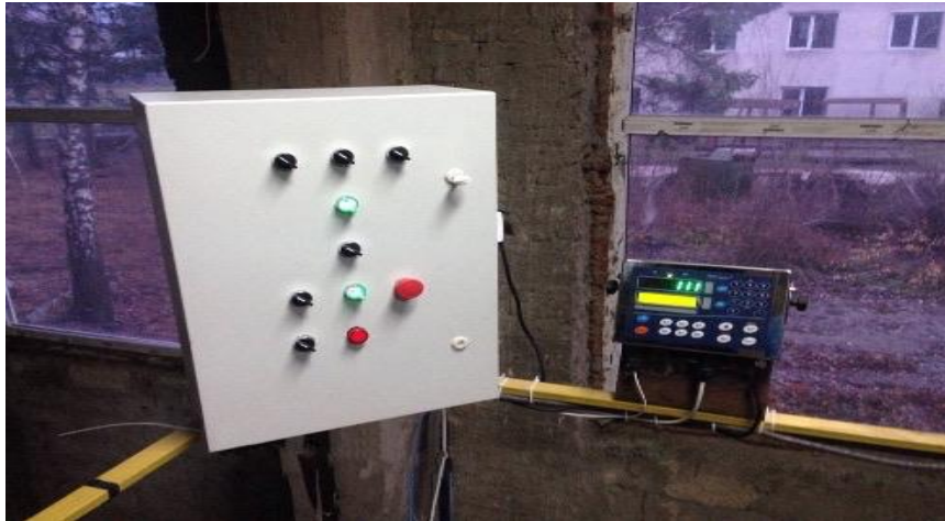
Рисунок 4.6 – Пульт управління комплексом БЗУ-60
