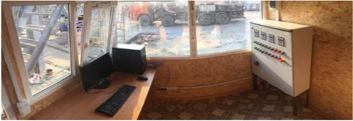
Рисунок 4.2 – Пункт управління комплексом БЗУ-60
