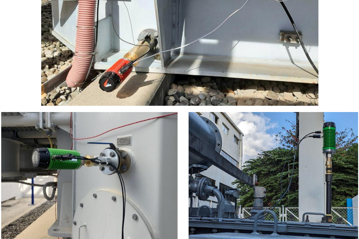
Рис. 3.3. Приклади місця установки сенсорів
