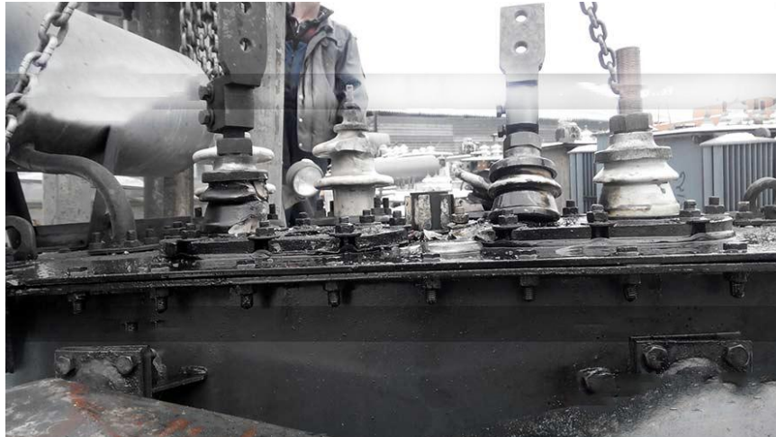
Рис. 1.1. Приклад пошкодження введів силового трансформатора
