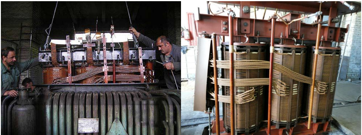
Рис. 1.4. Стан активної частини трансформатора при правильній експлуатації протягом 50 років
