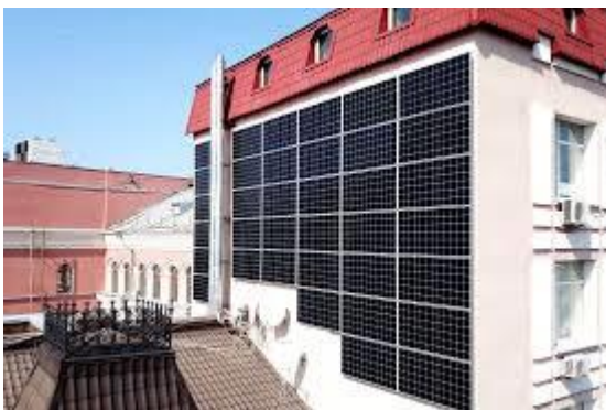
Рисунок 3.2 – Розміщення сонячних панелей на фасаді багатоквартирного будинку
