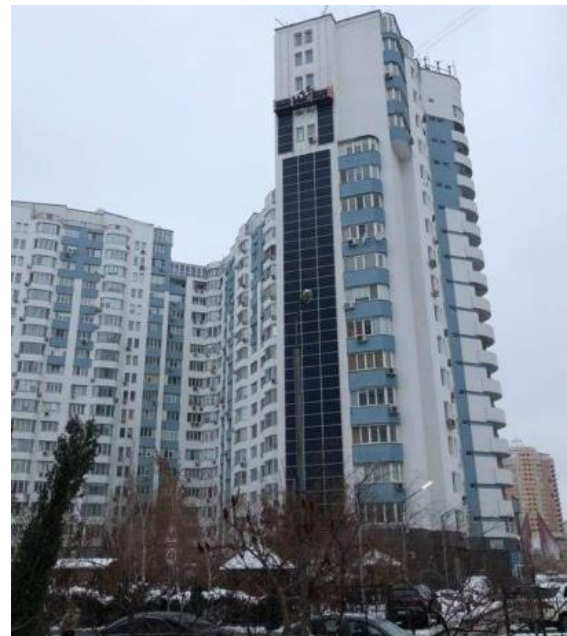
Рисунок 3.2 – Розміщення сонячних панелей на фасаді багатоквартирного будинку
