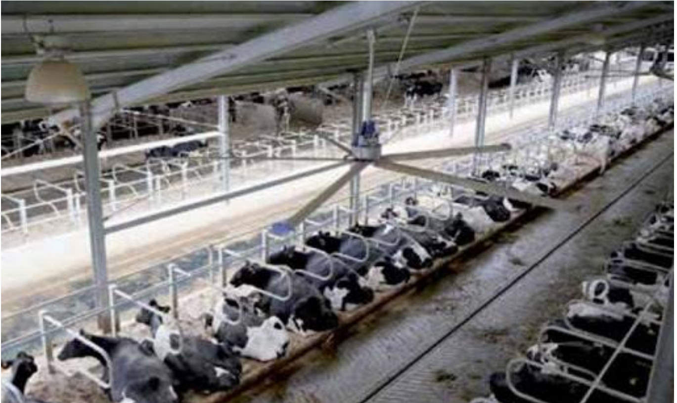
Рисунок 1.2. Системи вентилявання тваринницького приміщення
