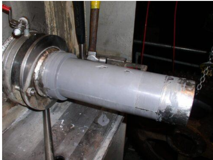
Рисунок 1.7 - Ремонт валу розчином Belzona
