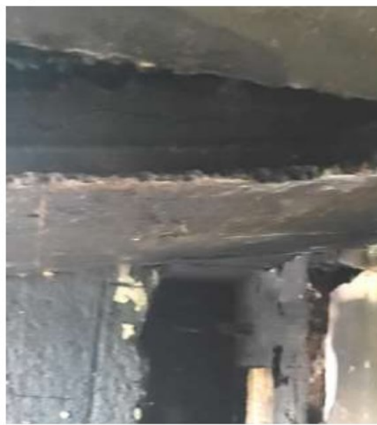
Ф.12,13 Руйнування плити перекриття на 5 поверсі
