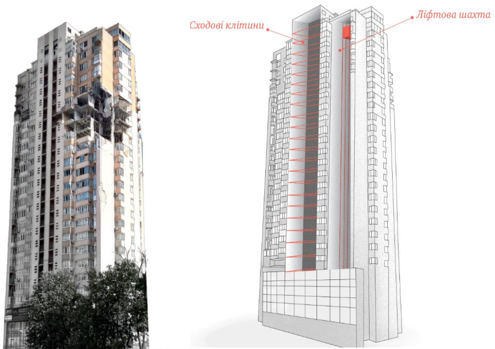
Рисунок 2.1. Фото пошкодженого будинку
