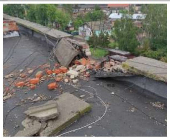
Ф.8,9 Руйнування плити покриття, парапету, плит парапету, м'якої покрівлі, оголовку вентканалу
