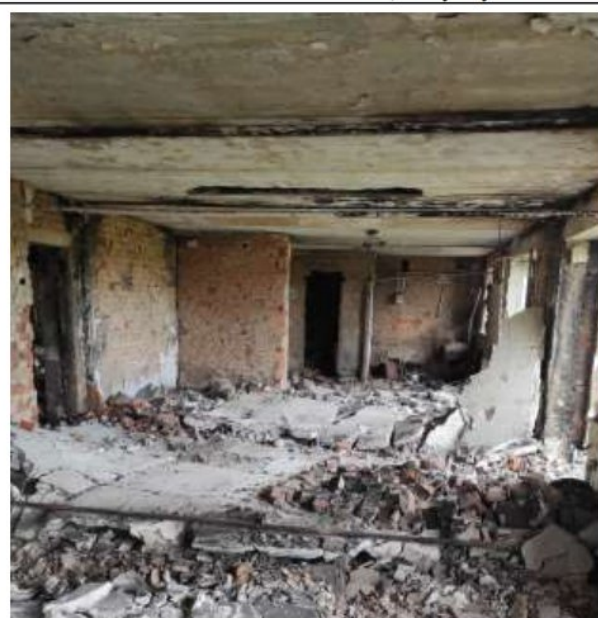
Ф.12,13 Руйнування плити перекриття на 5 поверсі
