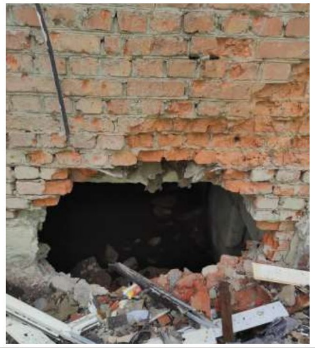
Ф.6,7 Наскрізний отвір в цегляній кладці цоколя, пошкодження фундаментного блока, руйнування віконних рам, балконів, пошкодження опорядження фасадів
