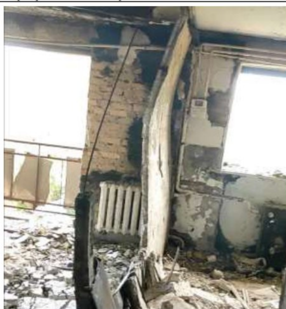
Ф.12,13 Руйнування плити перекриття на 5 поверсі
