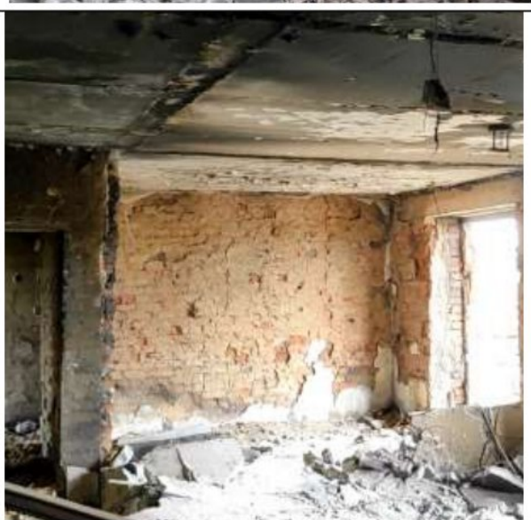
Ф.14-17 Руйнування внутрішнього оздоблення, інженерних мереж, перегородок, вікон, дверей, балконів
