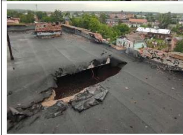
Ф.8,9 Руйнування плити покриття, парапету, плит парапету, м'якої покрівлі, оголовку вентканалу
