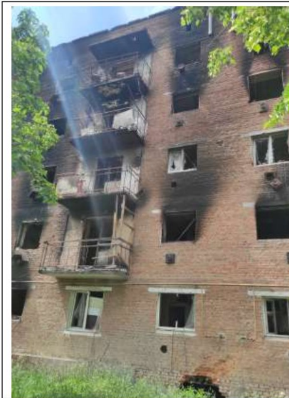
Ф.6,7 Наскрізний отвір в цегляній кладці цоколя, пошкодження фундаментного блока, руйнування віконних рам, балконів, пошкодження опорядження фасадів
