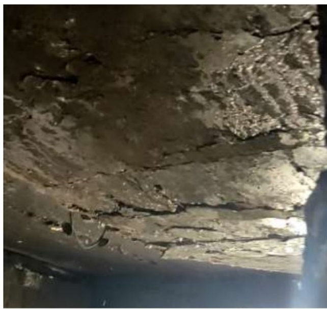
Ф.12,13 Руйнування плити перекриття на 5 поверсі
