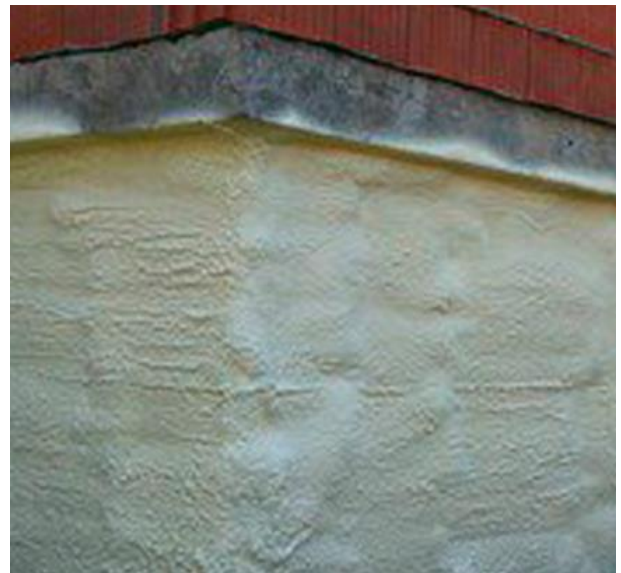
Рис.3. Приклад утеплення фундаментної зони за допомогою пінополіуретану
