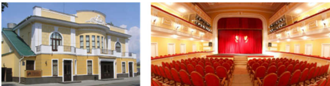
Фото 3.2. Фасад головного входу та внутрішній вигляд зали
