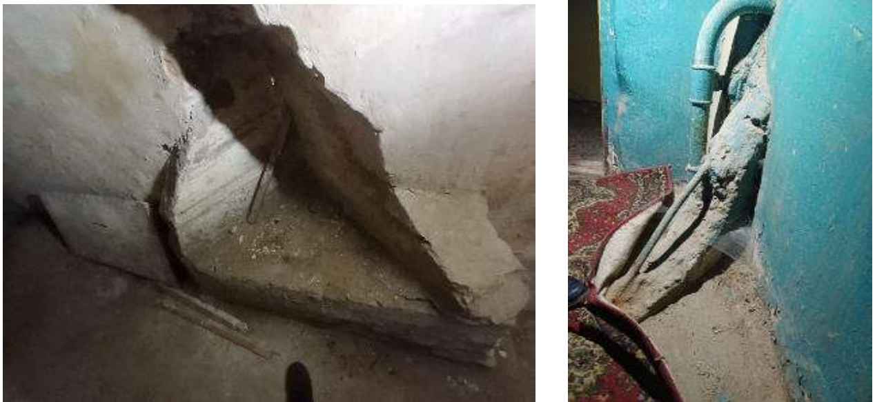
Фото 3.3. Частини фундаментів стаканного типу в підвальному поверсі
