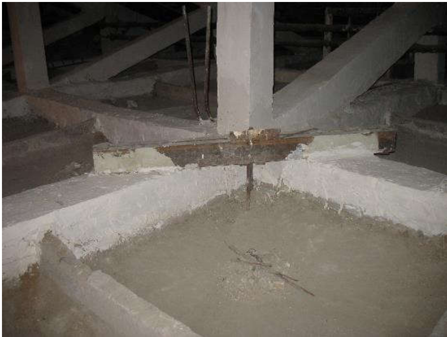
Фото 3.4. Просвердлені отвори в перекритті
