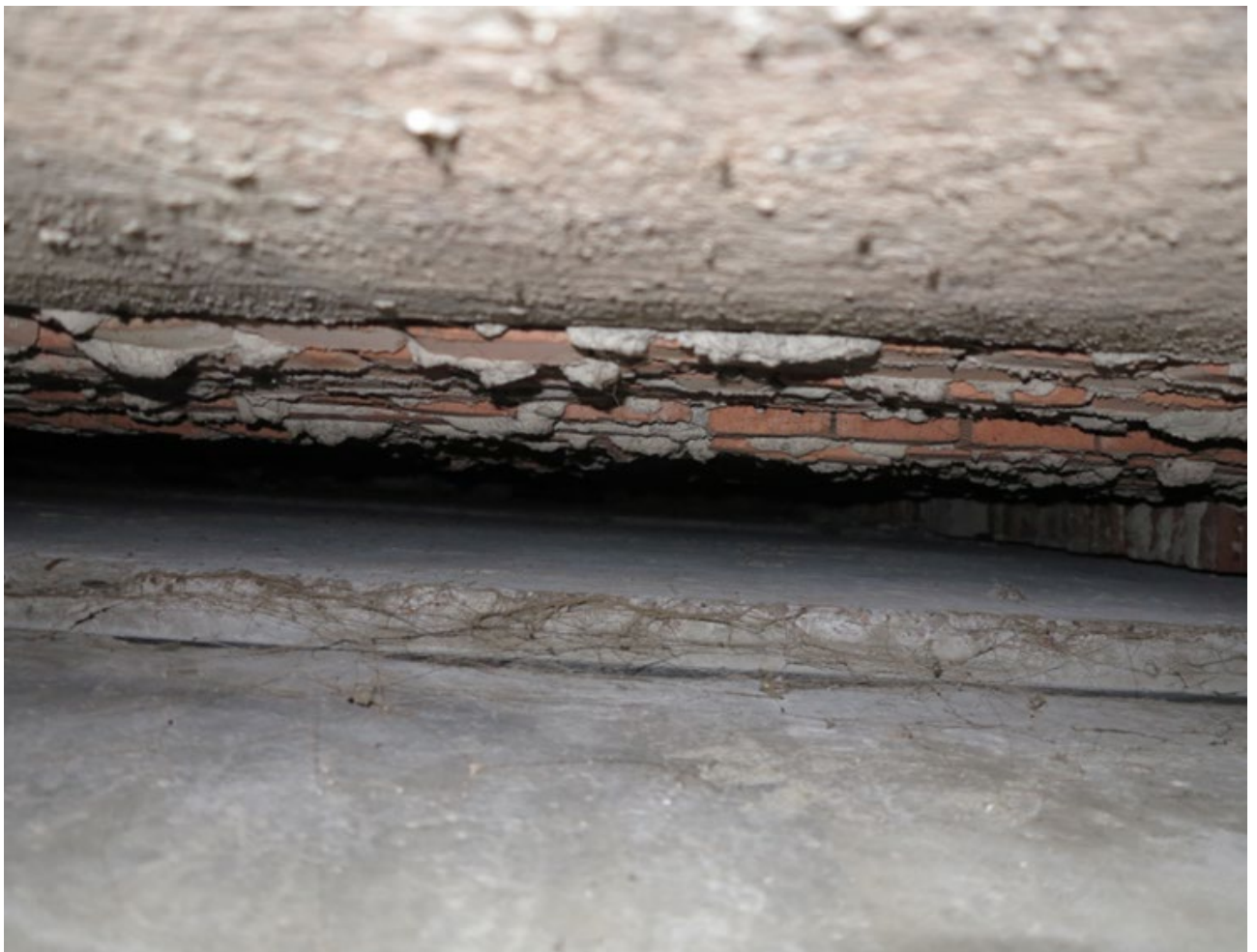
Рис. 2.14. Вигляд осадочного шва на рівні цокольного поверху
