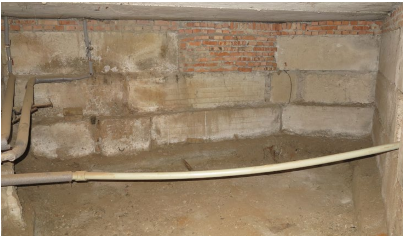
Рис. 2.10. Загальний вигляд стін цокольного поверху
