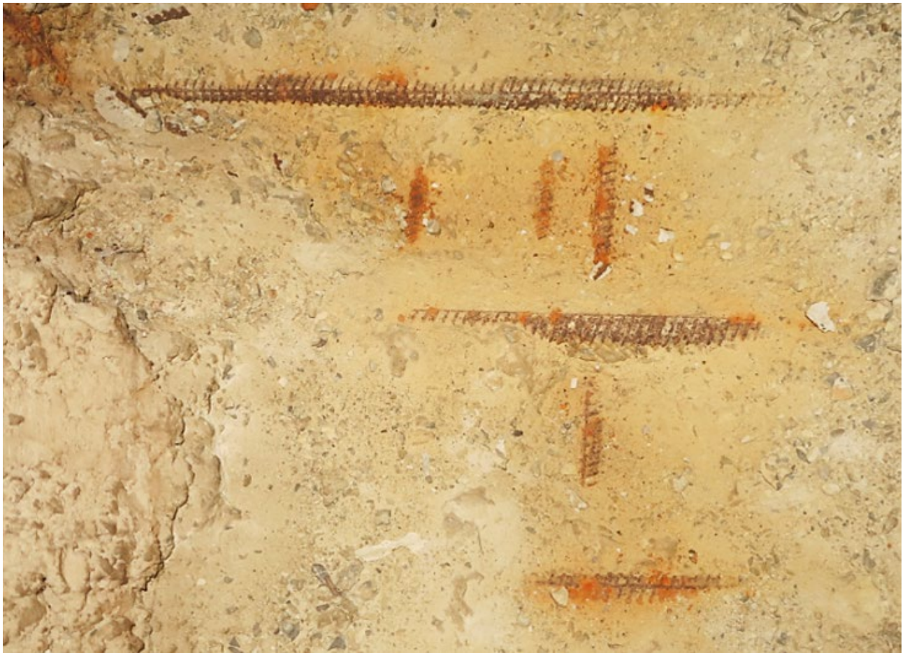
Рис. 2.9. Розкрита арматури фундаментної плити
