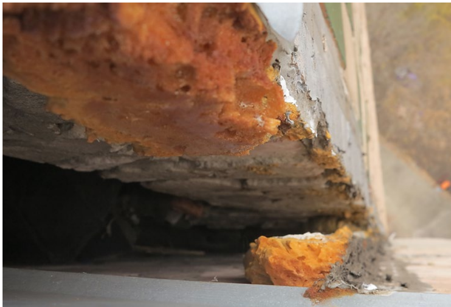
Розкриття осадочного шва з боку заднього (вуличного) фасаду
