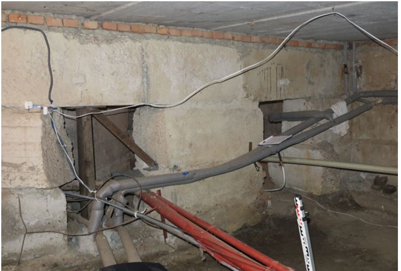
Рис. 2.11. Отвори та комунікації в стінах цокольного поверху
