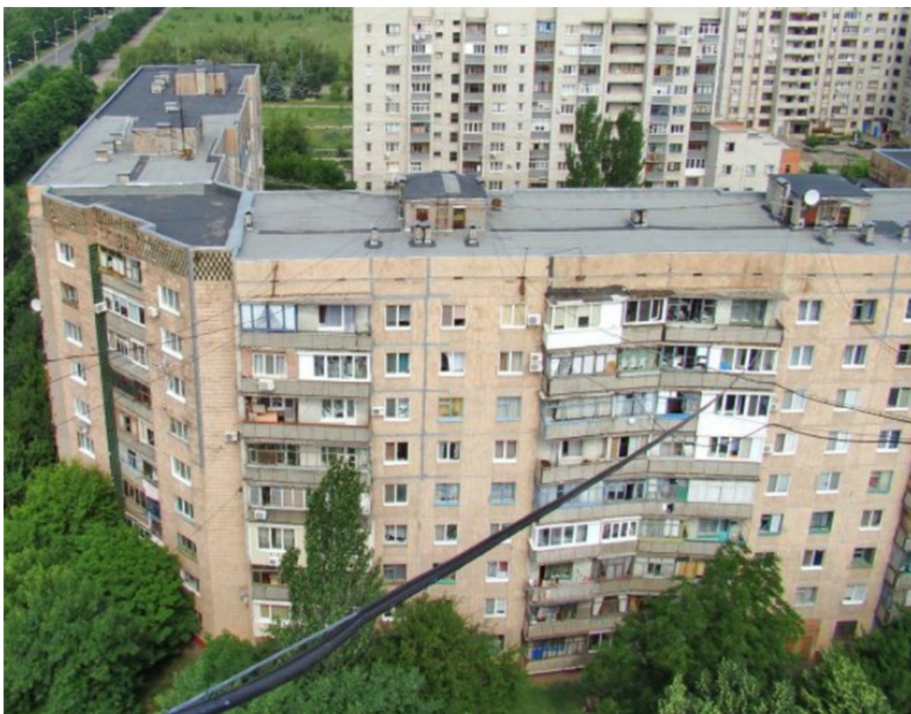
Рис. 2.1. Загальний вигляд будівлі та кутової секції-вставки
