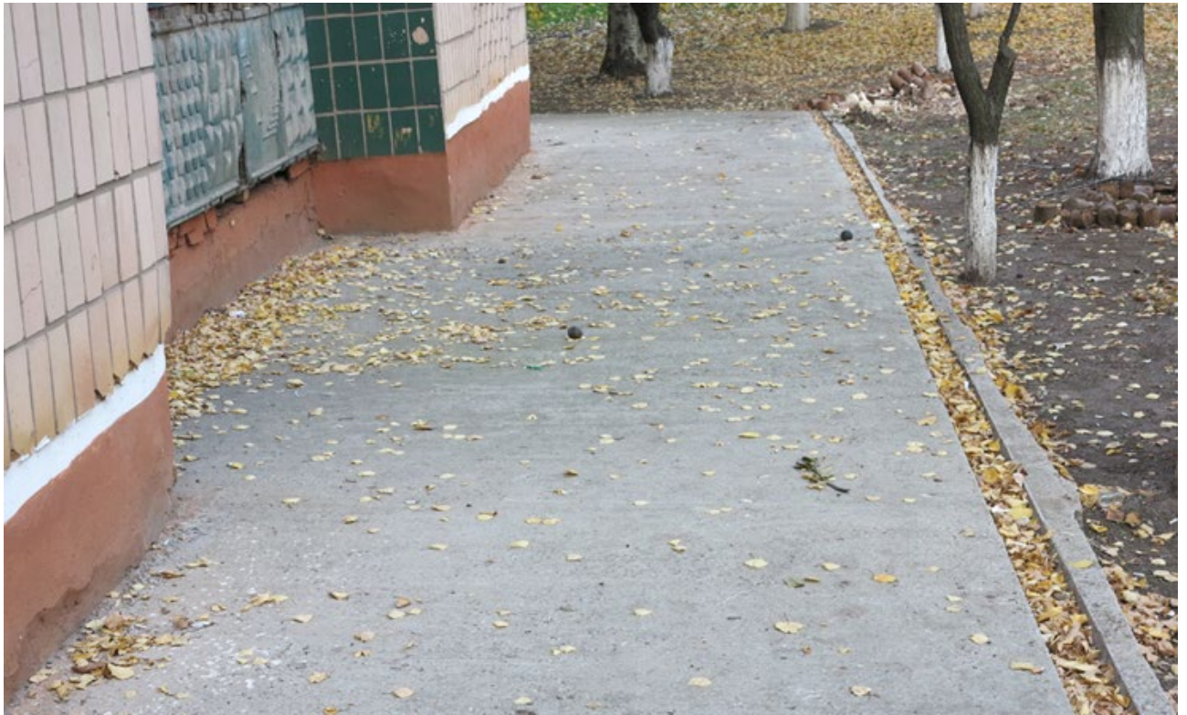
Рис. 2.13. Загальний вигляд вимощення заднього фасаду будівлі
