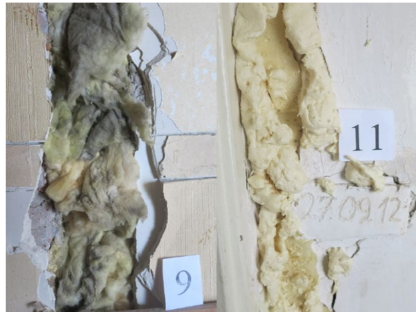
Руйнування відкосів в дверних отворах 5, 9-го поверхів
