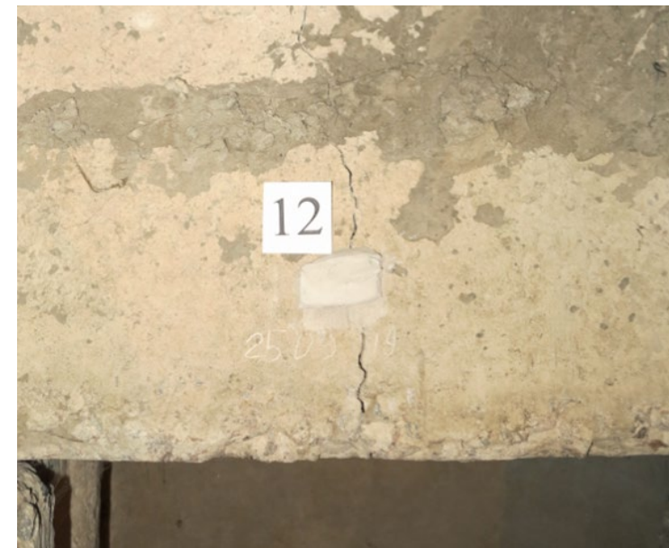
Кам'янистий бетон цоколя, тріщини в фундаментних блоках
