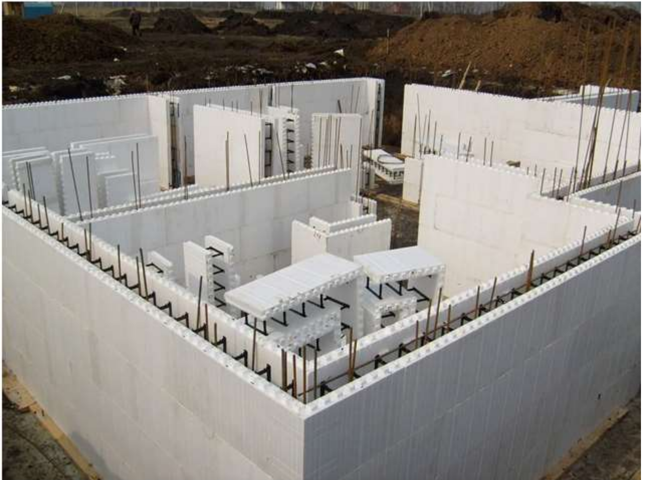
Рис. 1.10. Незнімна опалубка з полістиролбетону
