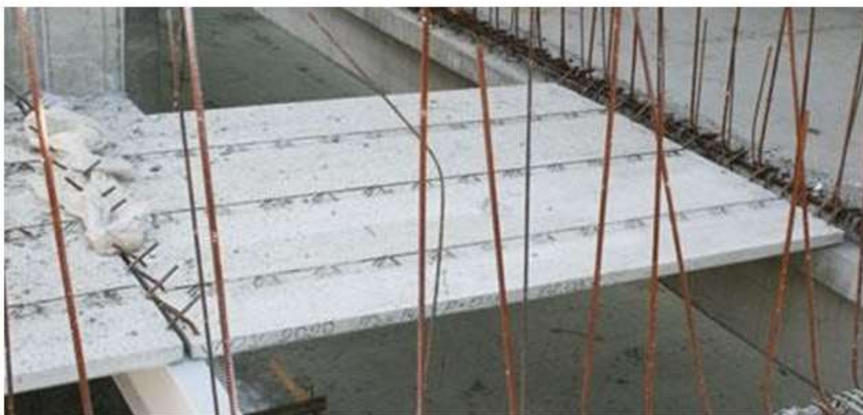
Рис. 1.19. Укладання нижньої частини незнімної опалубки
