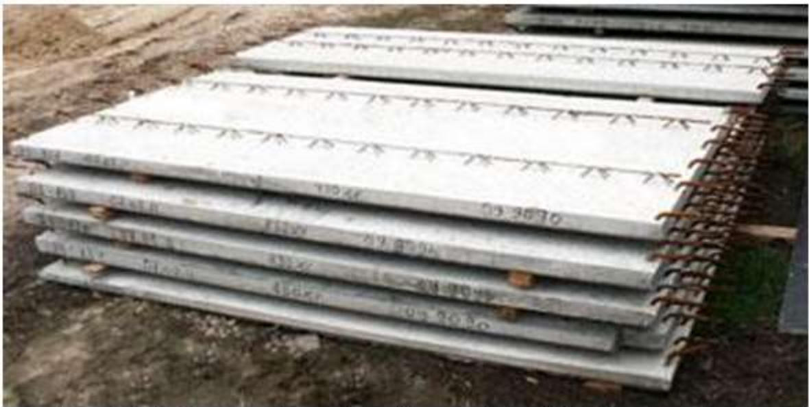
Рис. 1.20. Складові незнімної опалубки Обербетон
