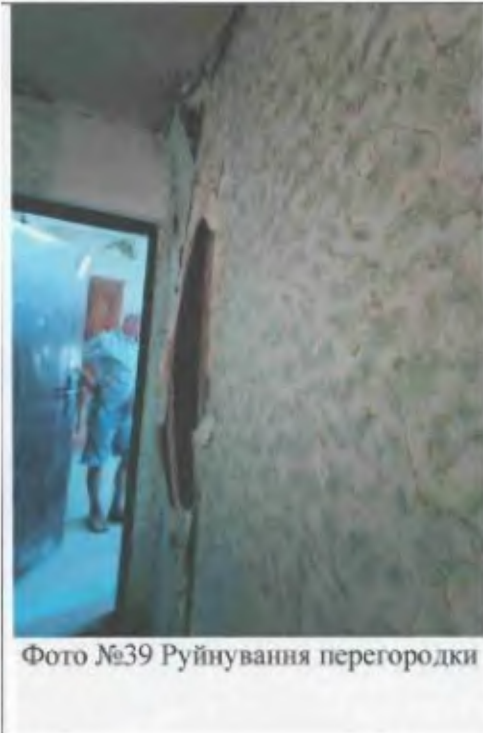
Фото №40 Руйнування перегородки
