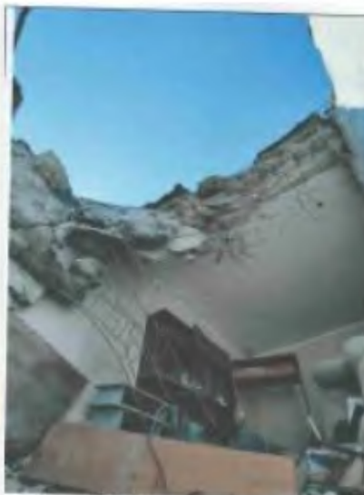
Фото №25 Руїнування панелей покриття
