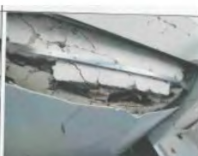
Фото №36 Руїнування панелей перекриття
