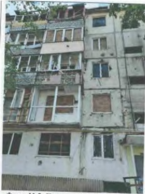
Фото №5. Головний фасад будівлі
