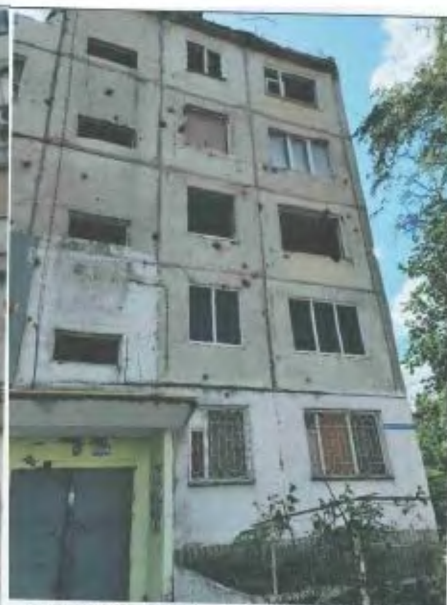
Фото №9. Головний фасад будівлі
