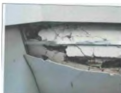
Фото №35 Руїнування панелей перекриття
