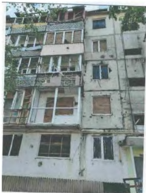
Фото №5. Головний фасад будівлі
