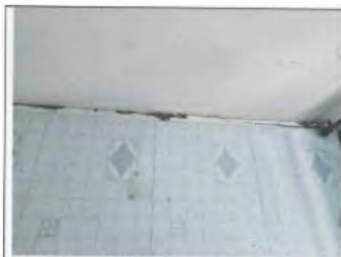
Фото №43 Висипання швів примикання стінової панелі та панелі перекриття
