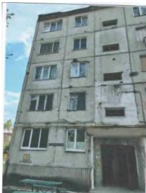
Фото №1. Головний фасад будівлі
