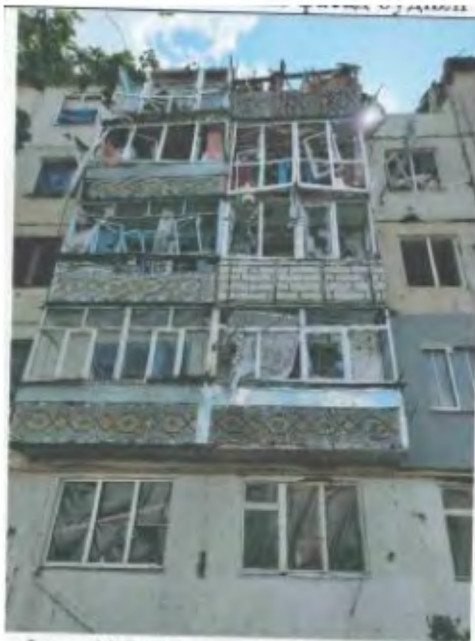
Фото №7. Головний фасад будівлі
