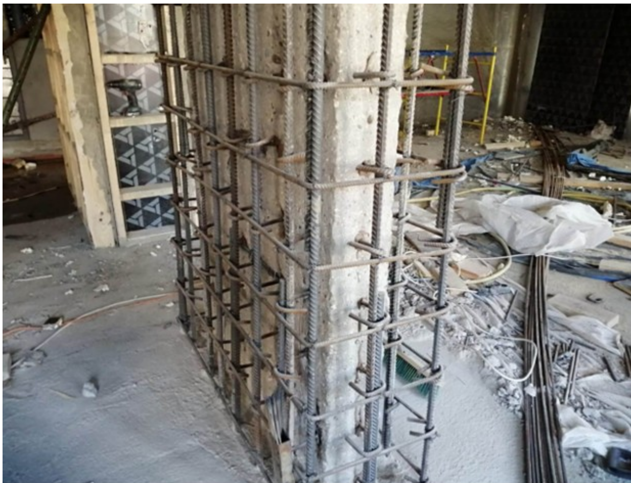
Рис. 2.1. Використання залізобетонних каркасів
