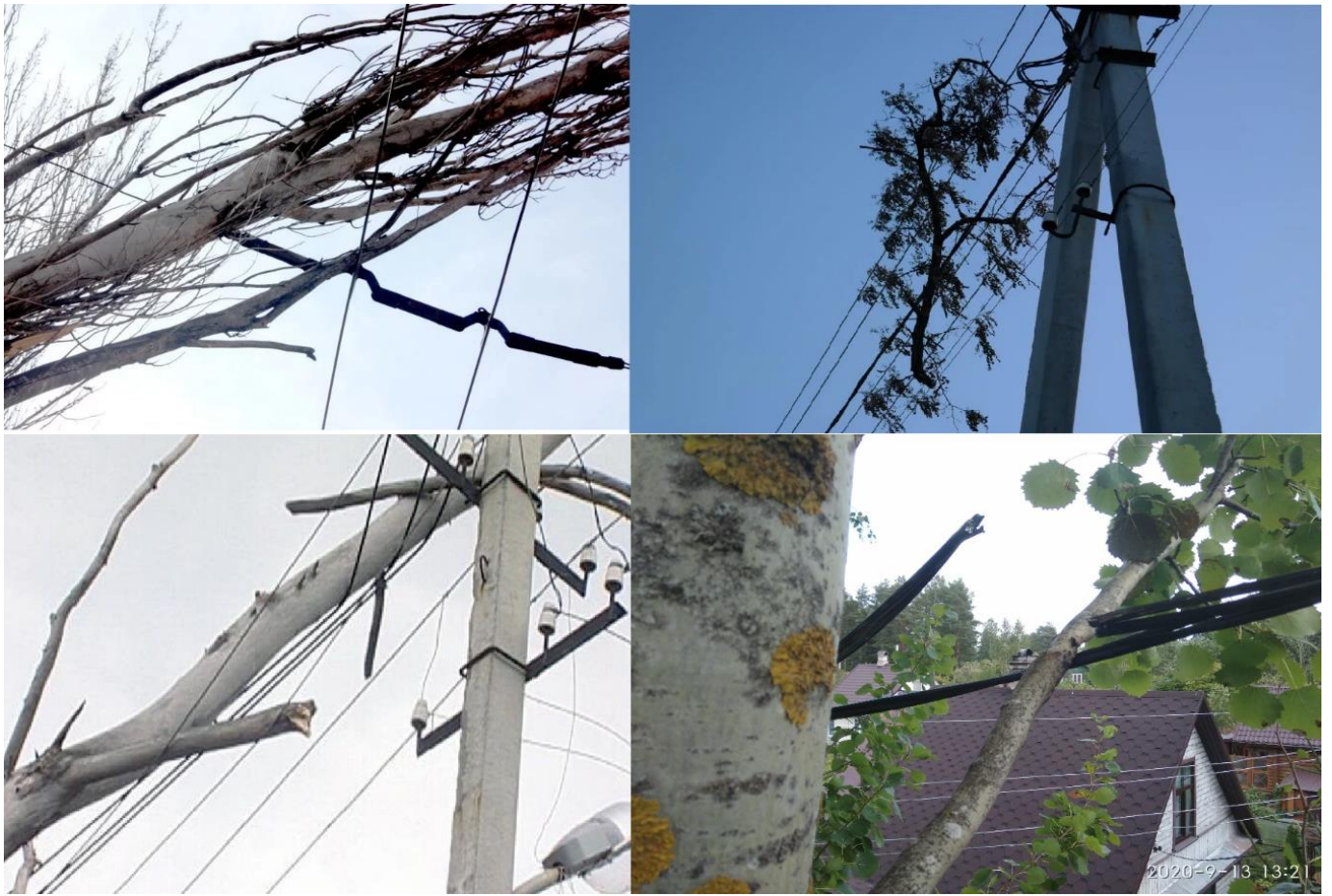
Рисунок 2.1. Вплив зарослих лісів та посадок на стан ліній електропередачі
